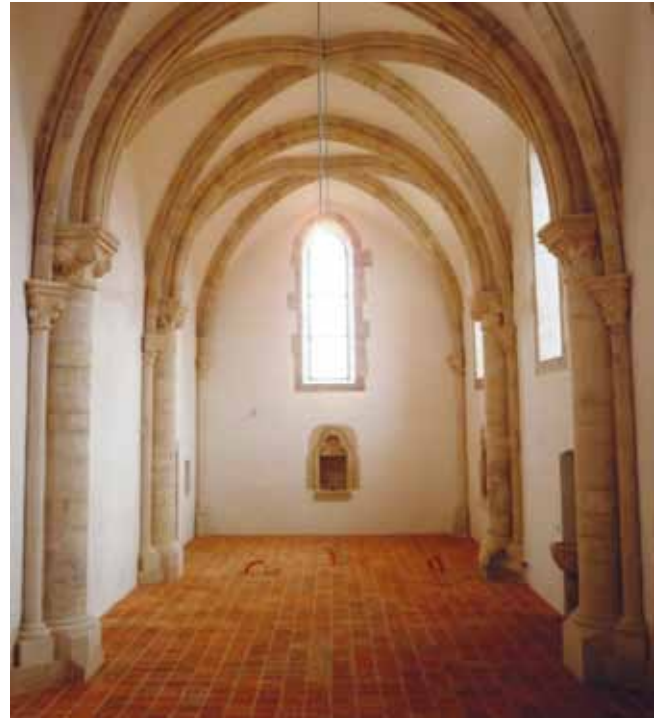
SLIKA 6. Pogled na unutrašnjost Crkve Uznesenja Blažene Djevice Marije u Gori (snimio J. Belaj).
