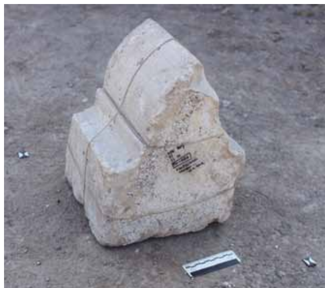
SLIKA 12. Rebro bademaste profilacije ivanovačke kapele u Pakracu (snimila V. Gligora).
