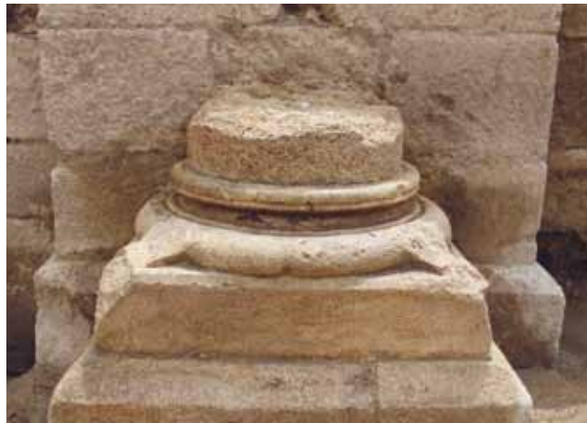
SLIKA 9. Baza polustupa u brodu ivanovačke kapele u Pakracu s ornamentom griffea na uglovima baze (snimio J. Belaj).
