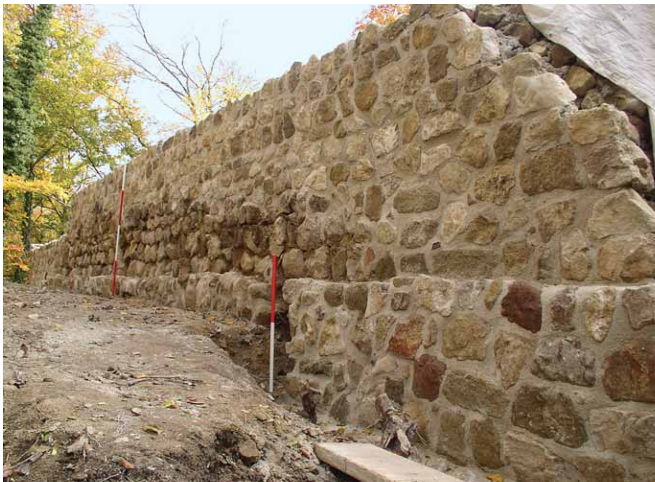
Sl. 41. Konzervirano sjeverno lice obodnog zida burga
