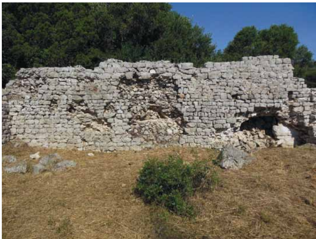
Slika 7. Zid B, pogled sa zapada (foto: T. Neuhauser).
