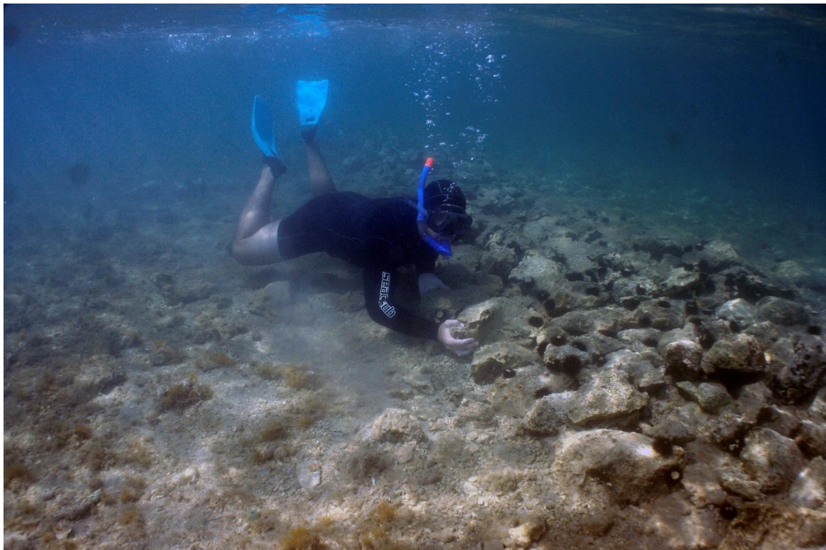
Slika 5 - Pogled na vanjski nasip potopljene konstrukcije
