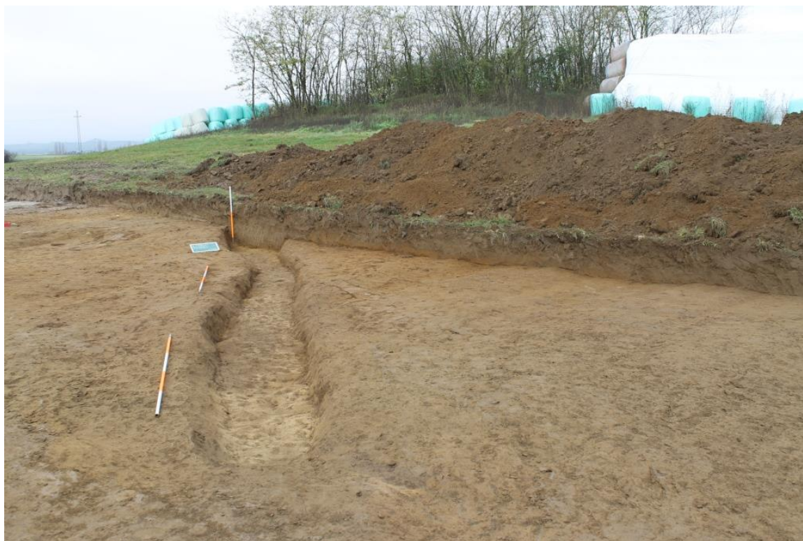
Sl. 14 Ukop kanala SJ 6 (foto: T.T.)
