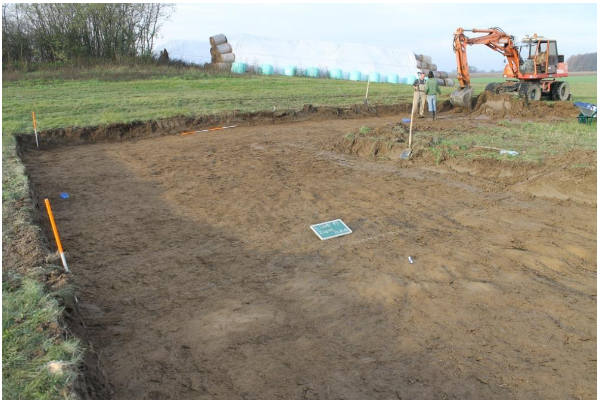
Sl. 9 Zapadni i sjeverozapadni dio sonde 1 bez arheoloških tvorevina izuzev recentnog SJ 19 i SJ 17/18, pogled od juga (foto: T. T)
