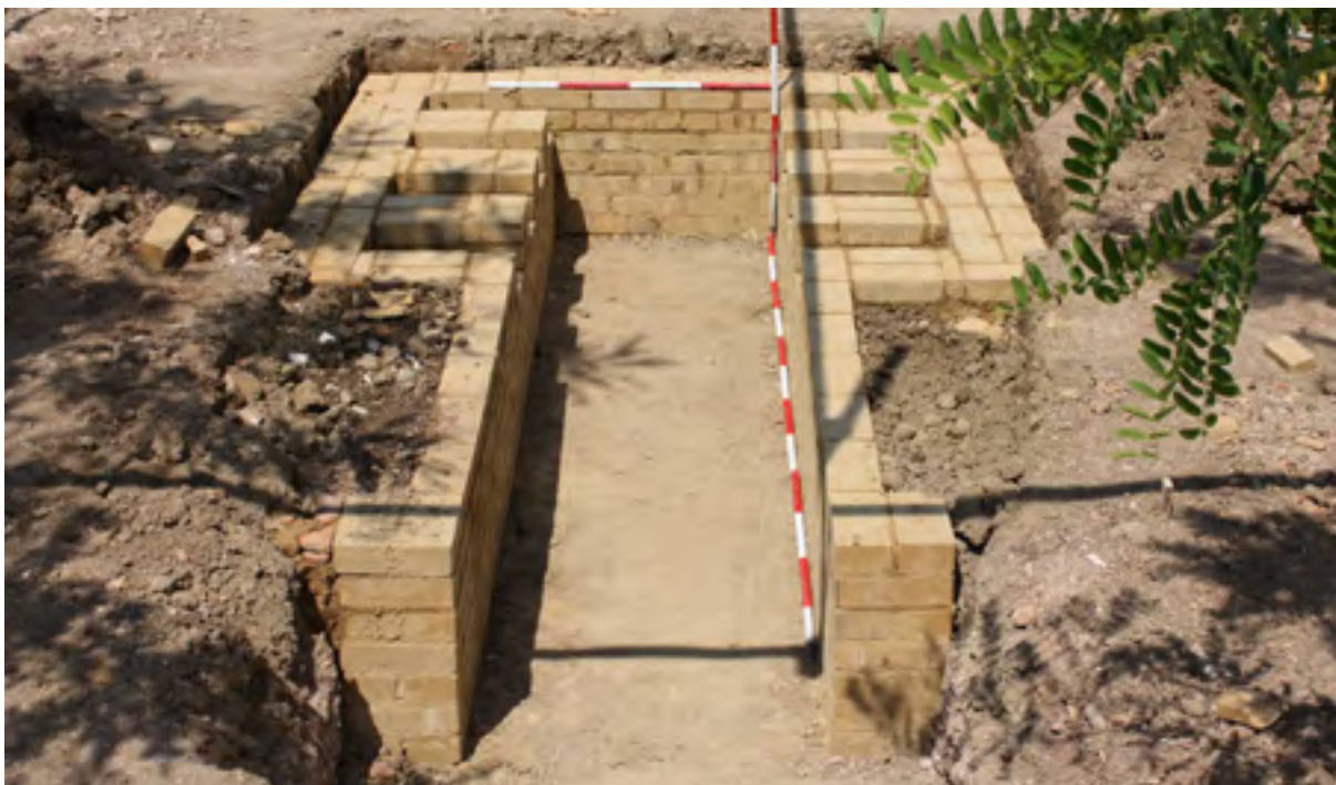
Sl. 10 Crikvenica - ukopani temelji replike crikveničke peći (foto: G. Lipovac Vrkljan)
