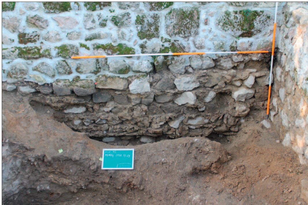
Sl. 4 Pogled od sjevera na temelj zida SJ 69 i ukop SJ 263 (snimio: S. Krznar)
