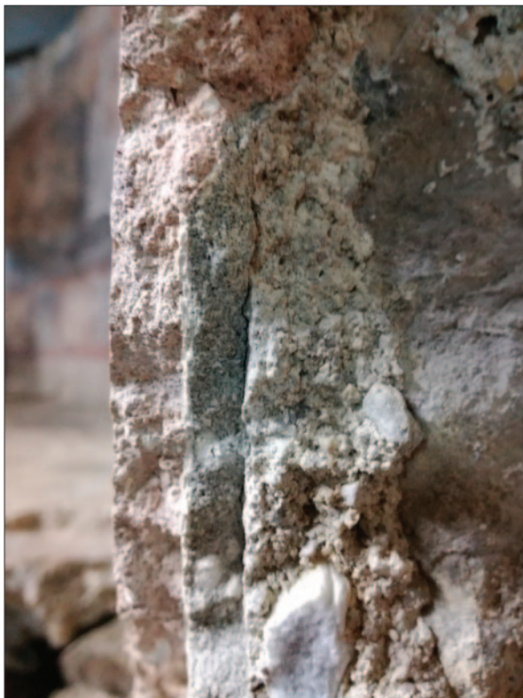
Sl. 10 Dubrovnik, podzemlje katedrale, Stratigrafija slojeva na presjeku zida apside (dokumentacija projekta)
