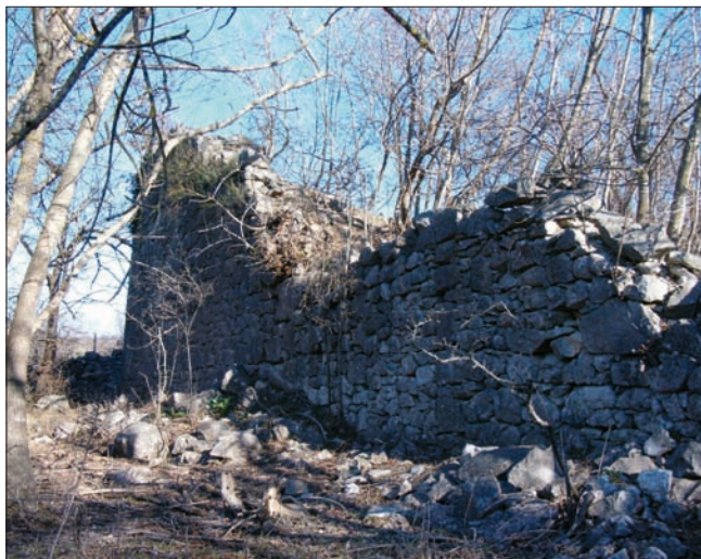
Sl. 7 Sjeverna kula "Furnaža" (M. Čaušević-Bully) Fig. 7 The northern tower "Furnaža" (M. Čaušević-Bully)
