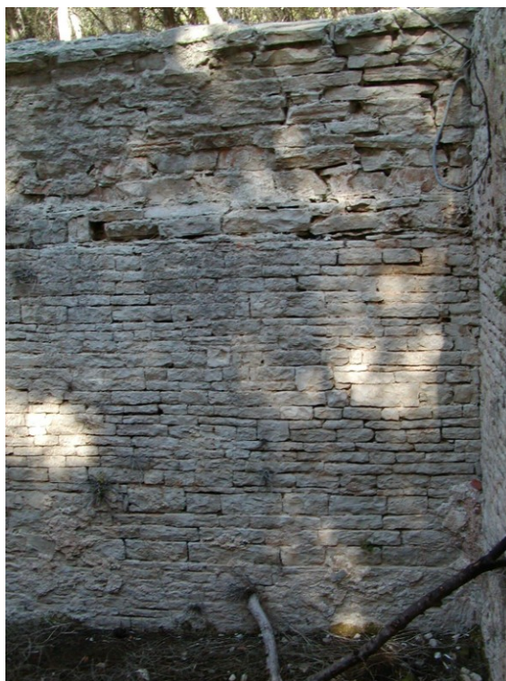
Sl. 27. Dio unutrašnje strane sjevernog zida cisterne u Bolu
