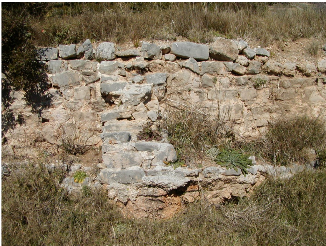
Sl. 58. Detalj južnog zida objekta na lokalitetu Murvica 1 sa kontraforima
