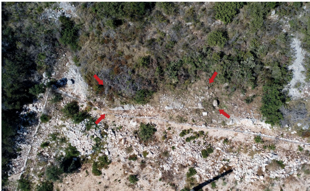
Sl. 2 Pogled na strukturu iz zračne perspektive (prije čišćenja) (snimio: P. Domines Peter) Fig. 2 Aerial view of the structure (before cleaning) (photo by: P. Domines Peter)
