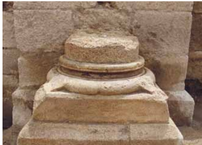
SLIKA 9. Baza polustupa u brodu ivanovačke kapele u Pakracu s ornamentom griftea na uglovima baze (snimio J. Belaj).
