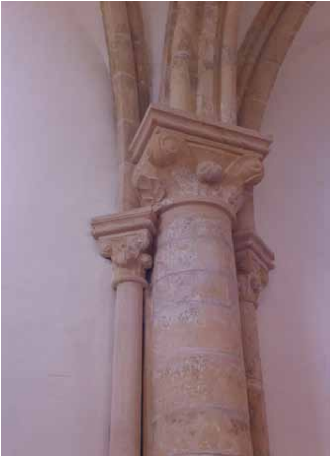
SLIKA 13. Pogled na svežnjasti nosač i rebro bademaste profilacije, Crkva Uznesenja Blažene Djevice Marije u Gori (snimio J. Belaj).
