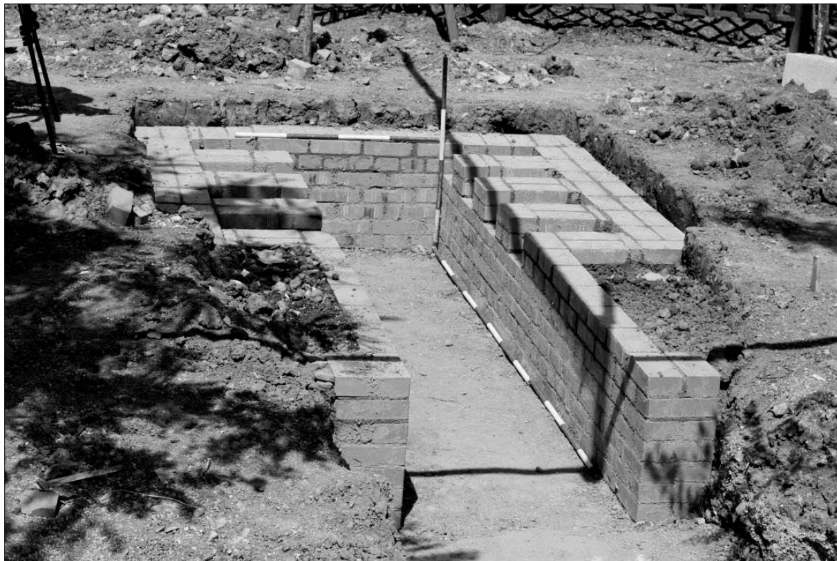
Sl. 1 Crikvenica – Strukture vatrišnog/ložišnog kanala i komore za izgaranje replike rimske keramičarske peći (snimila: G. Lipovac Vrkljan).
