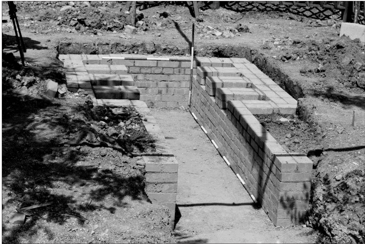
Sl. 1 Crikvenica – Strukture vatrišnog/ložišnog kanala i komore za izgaranje replike rimske keramičarske peći (snimila: G. Lipovac Vrkljan).
