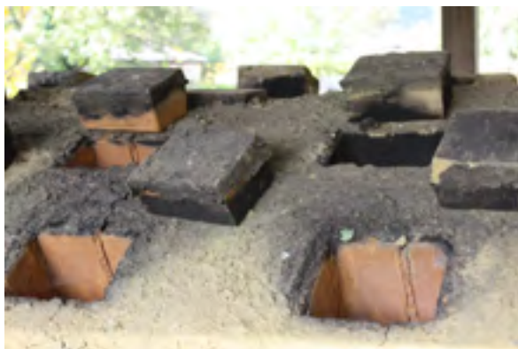
Sl. 19 Sustav pravilno raspoređenih ventilacijskih dimnih otvora na bačvastom svodu. Zatvaraju se i otvaraju pomoću (keramičkih) čepova (foto: G. Lipovac Vrkljan) Fig. 19 System is properly distributed ventilation flue openings in the barrel vault. Opens and closes using the (ceramic) caps (photo: G. Lipovac Vrkljan)
