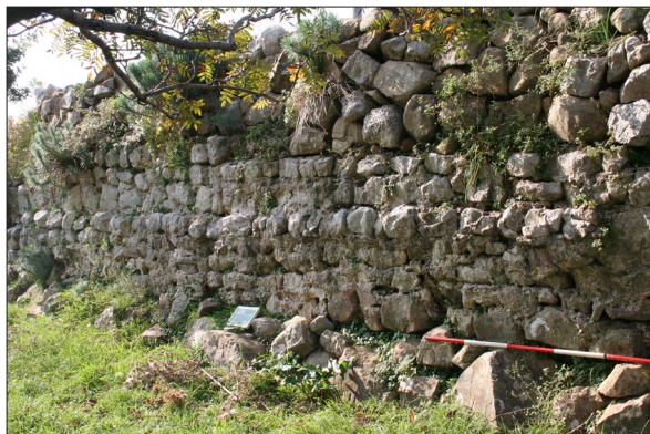
Sl. 1 Lokalitet 70, struktura 1 – elevacija zida od lomljenaca vezanih žbukom na kojeg je „dograđen“ suhozid (snimila: A. Konestra).
