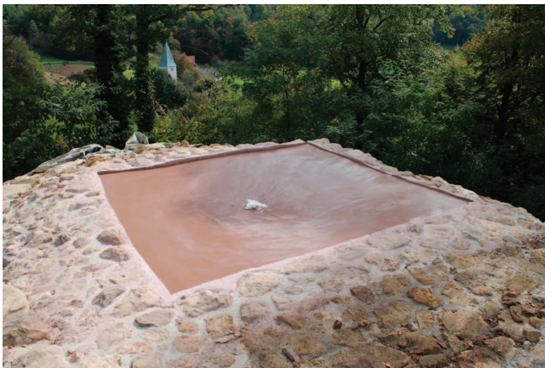
Sl. 10 Unutrašnjost kule nakon konzervacije – završno stanje (snimio: S. Krznar)
