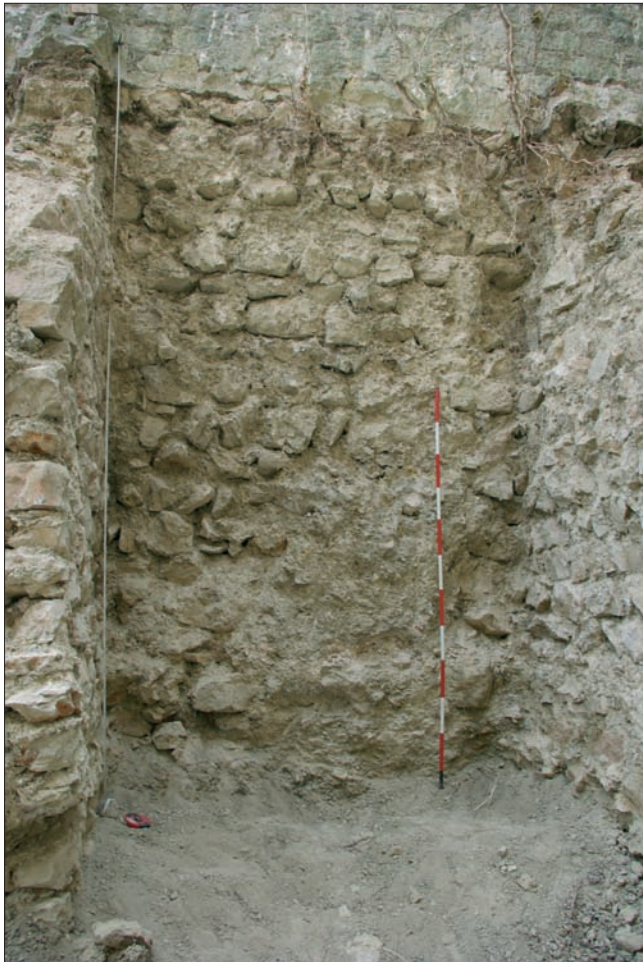
Sl. 12 Unutrašnje lice istočnog zida Barbakana Fig. 12 Inner face of the eastern wall of the Barbakan
