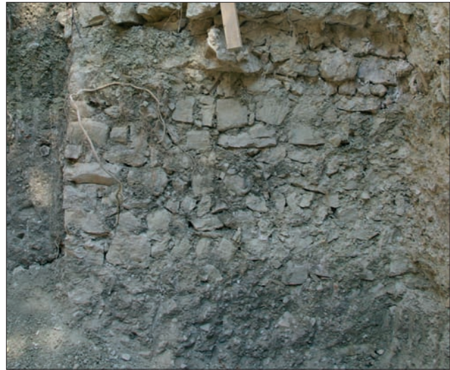
Sl. 13 Unutrašnje lice sjevernog zida Barbakana Fig. 13 Inner face of the northern wall of the Barbakan
