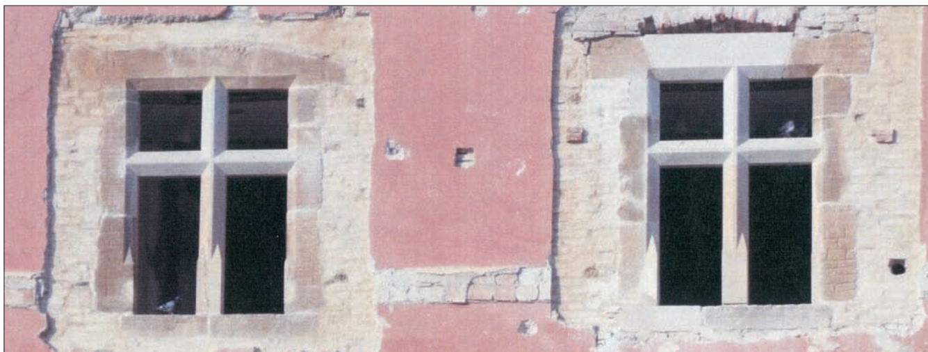
Sl. 12 Ilok – palača Odescalchi, nekadašnji palas knezova Iločkih, južno pročelje II. kata (foto: Đ. Šimičić)
