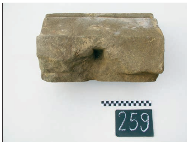
Sl. 7 Burg Vrbovec, PN 259 – desna baza profilacije prozora s tragovima naknadnoga nasilnog oštećenja utora za ugrađivanje željezne rešetke (foto: T. Tkalčec)
