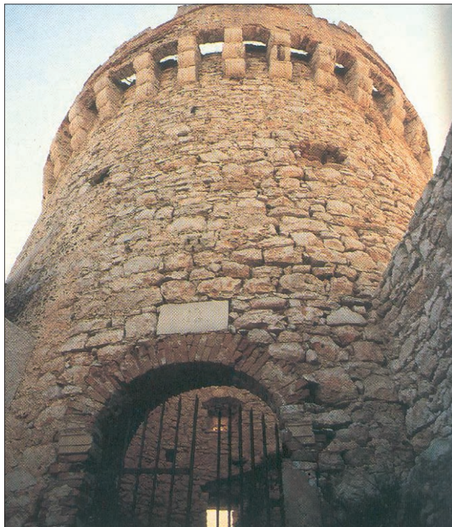
Sl. 1 Obrambena kula iz XV. st. na predjelu Kaštel u Velološinjskoj uvali
