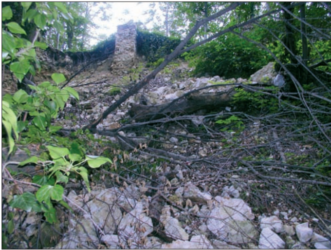
Sl. 3 Pregradni zid vidljiv nakon urušenja sjevernoga zida burga (snimio J. Belaj)
