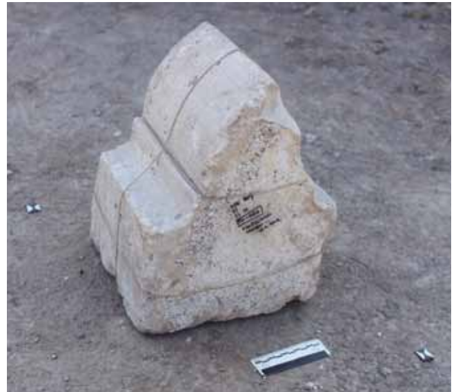
SLIKA 12. Rebro bademaste profilacije ivanovačke kapele u Pakracu (snimila V. Gligora).
