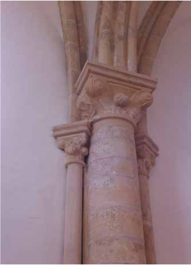
SLIKA 13. Pogled na svežnjasti nosač i rebro bademaste profilacije, Crkva Uznesenja Blažene Djevice Marije u Gori (snimio J. Belaj).
