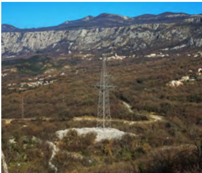
Tumul Stolnič, uništen prilikom postavljanja dalekovodnoga stupa (snimio: S. Špalj)
