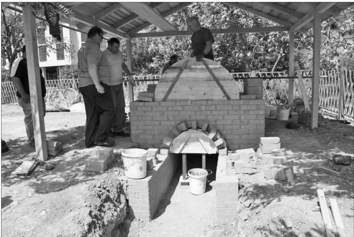
Sl. 5 Crikvenica – zidanje lučnog svoda peći (snimila: A. Konestra).
