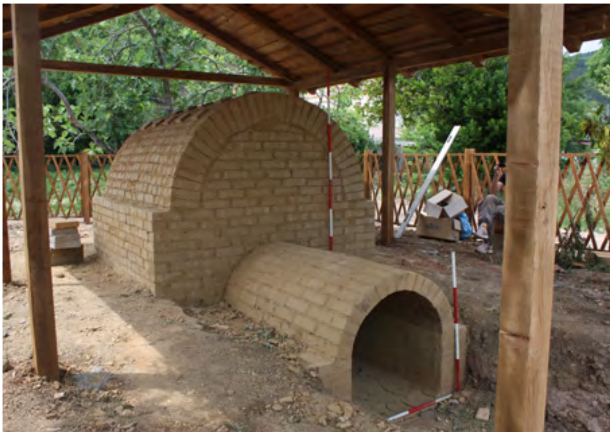
Sl. 17 Replika crikveničke rimske peći "Ignacija" - pokrov komore je bačvasti svod s ventilacijskim dimnim otvorima (foto: A. Konestra)
