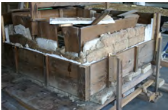
Fig. 4 La fornace dopo lo stacco con la struttura lignea messa in opera nel 1970 per la sua conservazione (Foto Diego Malvestio & C. snc) Sl. 4 Peč s drvenom strukturom nakon izmicanja za potrebe restauracije 1970. g. (Fotografija: Diego Malvestio & C. snc)
