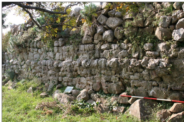
Sl. 1 Lokalitet 70, struktura 1 – elevacija zida od lomljenaca vezanih žbukom na kojeg je „dograđen“ suhozid (snimila: A. Konestra).
