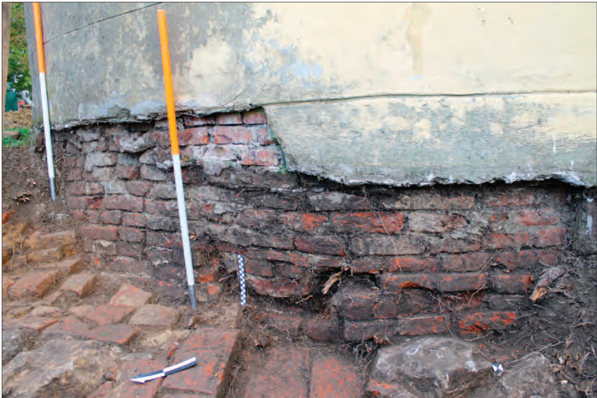
Sl. 18 Kula Zrinski, sonda 3 – pogled na temelj kule SJ 22 (mjerilo od 20 cm okomito postavljeno kod otvora za otpadne vode na koji se nadovezuje kanalice SJ 27) (snimila: T. Tkalčec)
