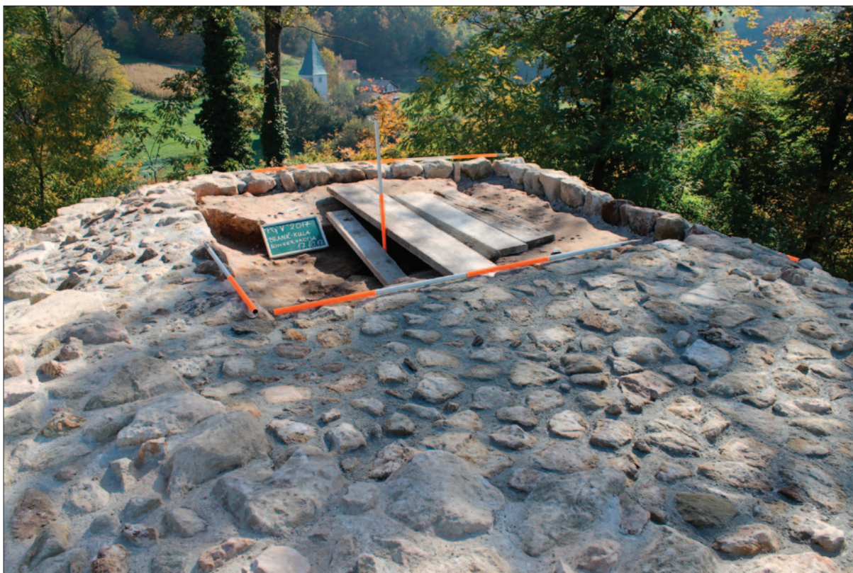
Sl. 4 Vrh kule nakon provedenih konzervatorskih radova, pogled od zapada (snimila: T. Tkalčec)
