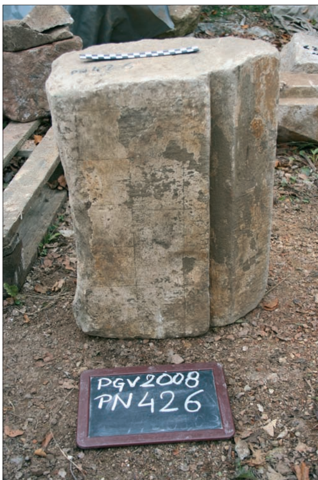
Sl. 6 Burg Vrbovec, PN 426 – lijeva baza profilacije prozora srednje veličine s ostacima žutog i oker bojanja kvadratičnih polja (foto: T. Tkalčec)
