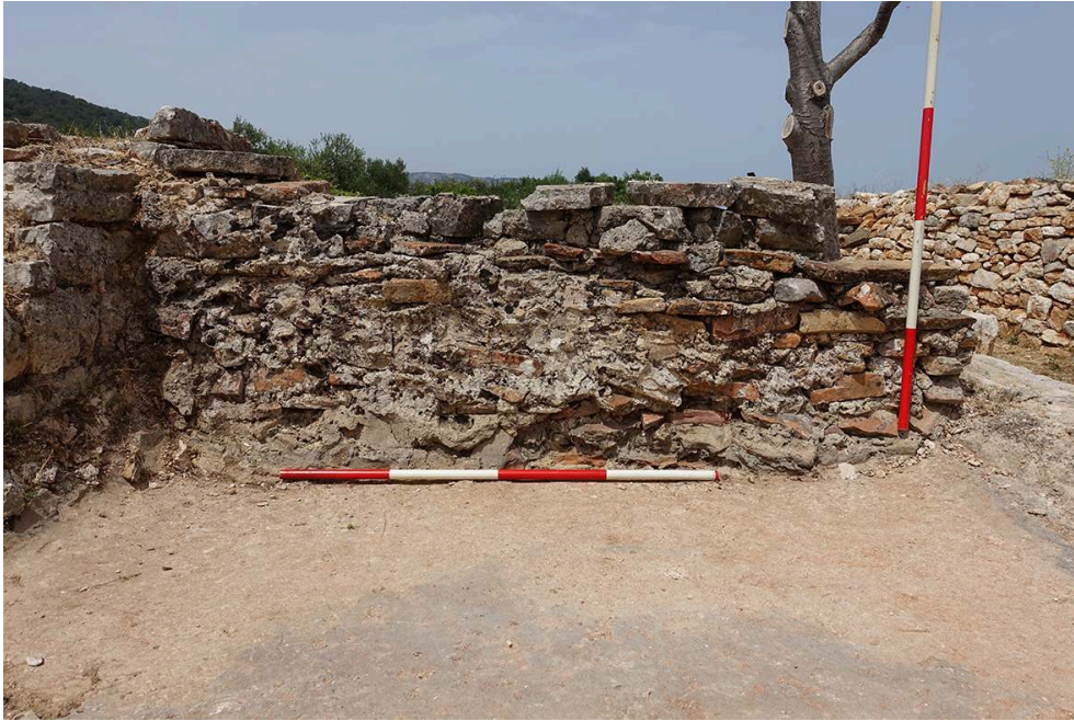
Fig. 10. Mur MR 1053 séparant les bassins BS 1051 et 1052.
